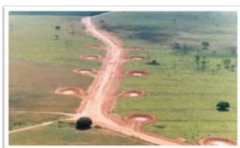
READEQUAÇÃO DE ESTRADAS (ESTRADAS ECOLÓGICAS)
