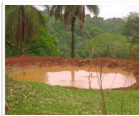
BACIAS DE INFILTRAÇÃO - BARRAGINHAS
