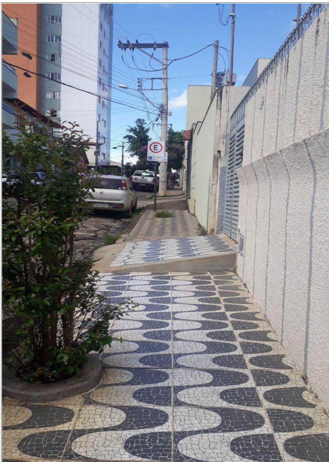
Foto de Calçada sem acessibilidade na Rua dos Operários
