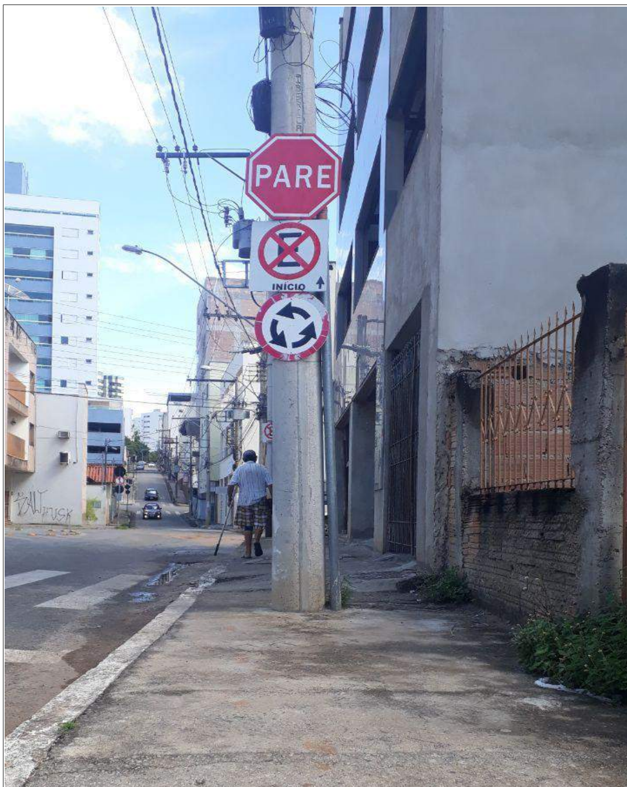
Foto de poste instalado no meio da calçada e obstruindo o caminho. Rua Coronel Tininho
