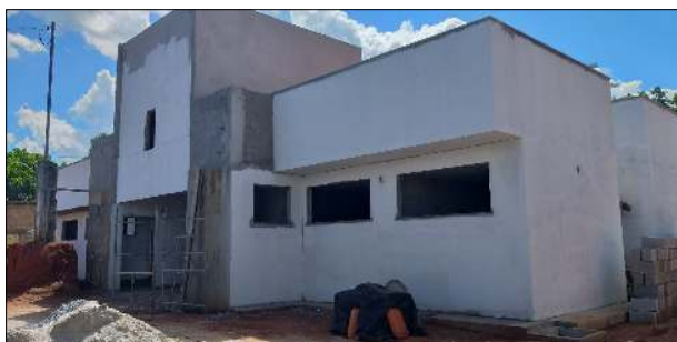
Construção Unidade de Saúde Rosalina Teodoro Engenho do Ribeiro
