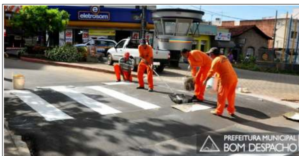
Foto 1: Sinalização horizontal faixa de pedestres
