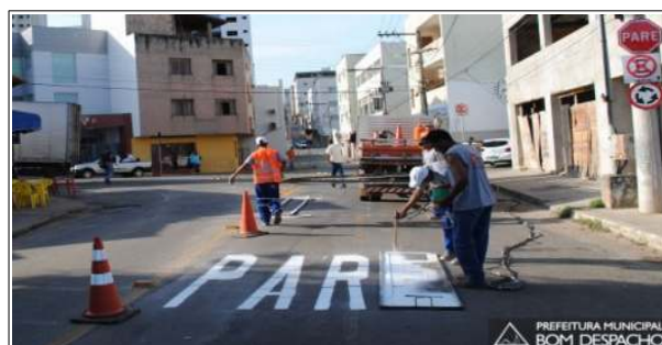
Foto 2: Sinalização horizontal na região central da cidade
