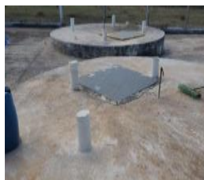
Filtro Anaeróbio
