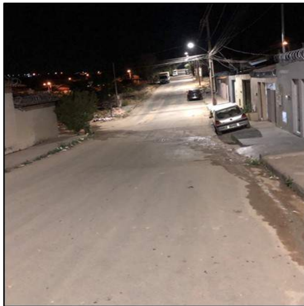
Depois da substituição por LED na Rua Bem-te-vi, Babilônia
