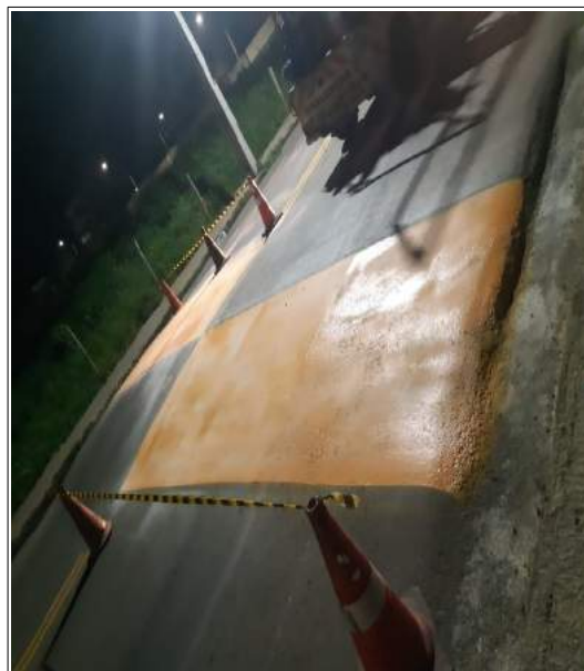
Fonte: Acervo próprio. Local: Rua Vivalde Brandão. Descrição: Demarcação de redutor de velocidade.
