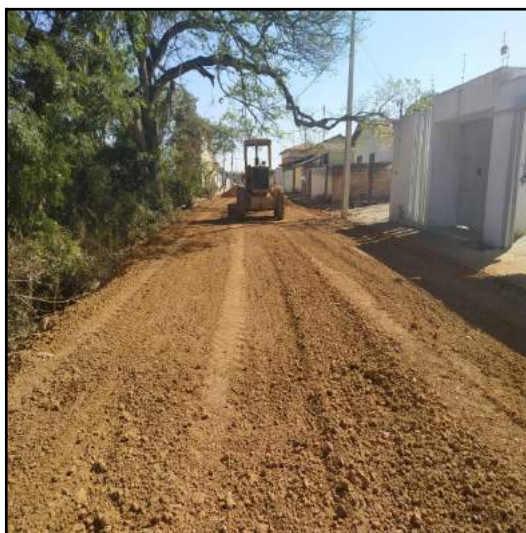
Execução de base para pavimentação da rua Martinho Bernardes, Santa Lúcia
