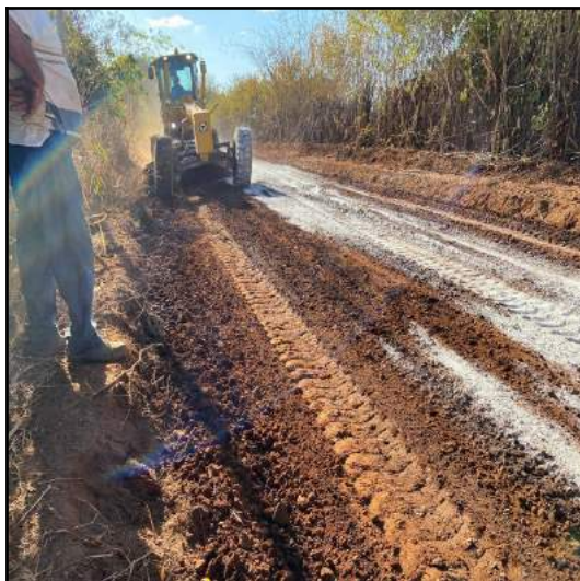
Aplicação do produto na Estrada da Passagem
