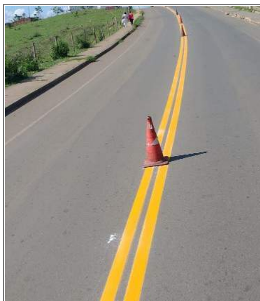
Fonte: Acervo próprio. Local: Av. Sandoval Mesquita. Descrição: Demarcação Horizontal de eixo.
