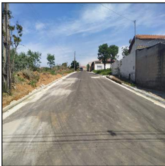
Pavimentação da Rua Prata, Babilônia
