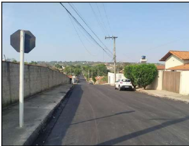
Recapeamento da Rua Chico Marques
