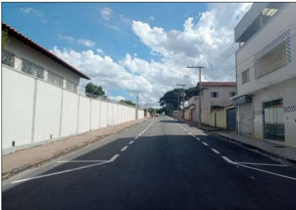
Demarcação horizontal de vagas de estacionamento
