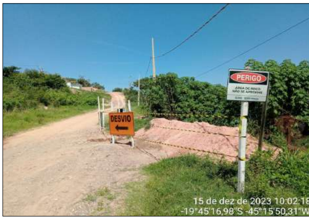
Interdição parcial preventiva da Defesa Civil, na Avenida Brasil
