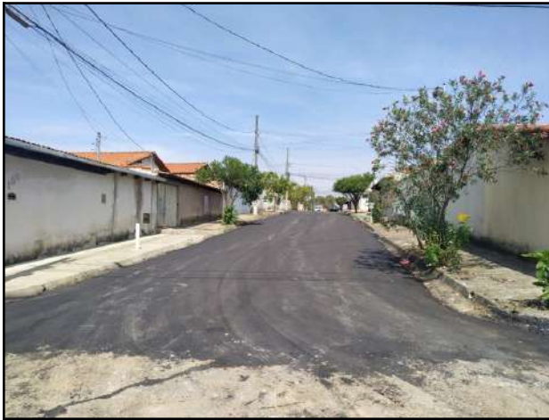
Recapeamento da Rua Zico Ferreira
