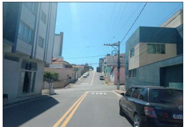
Demarcação de linha de fluxos opostos e inscrição de PARE no pavimento
